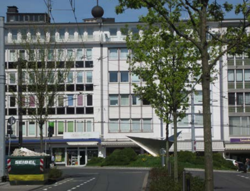
Kölner Straße, Ufergarten
