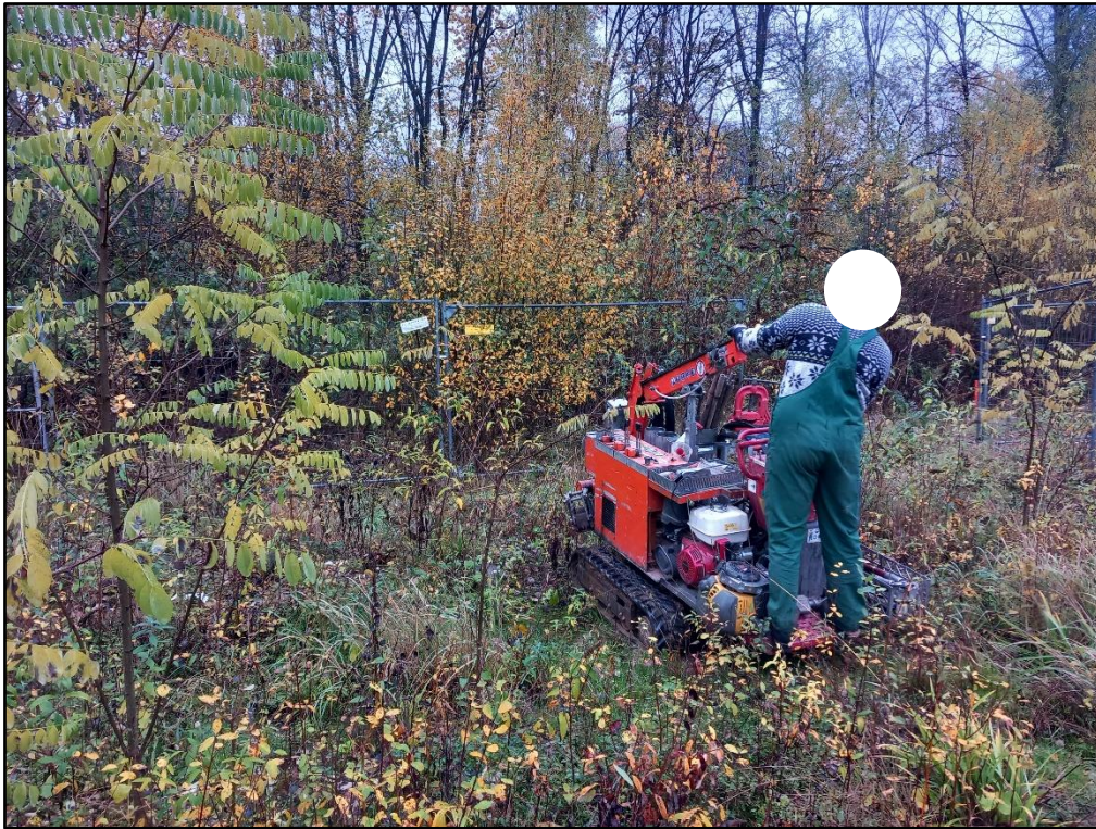
Abbildung 9: Beginn der Bohrarbeiten – Anfahrt mittels MRZB (mobiles Bohrgerät mit Kettenantrieb und hydraulisch betriebenen Bohrhammer) zu KRB 1.
