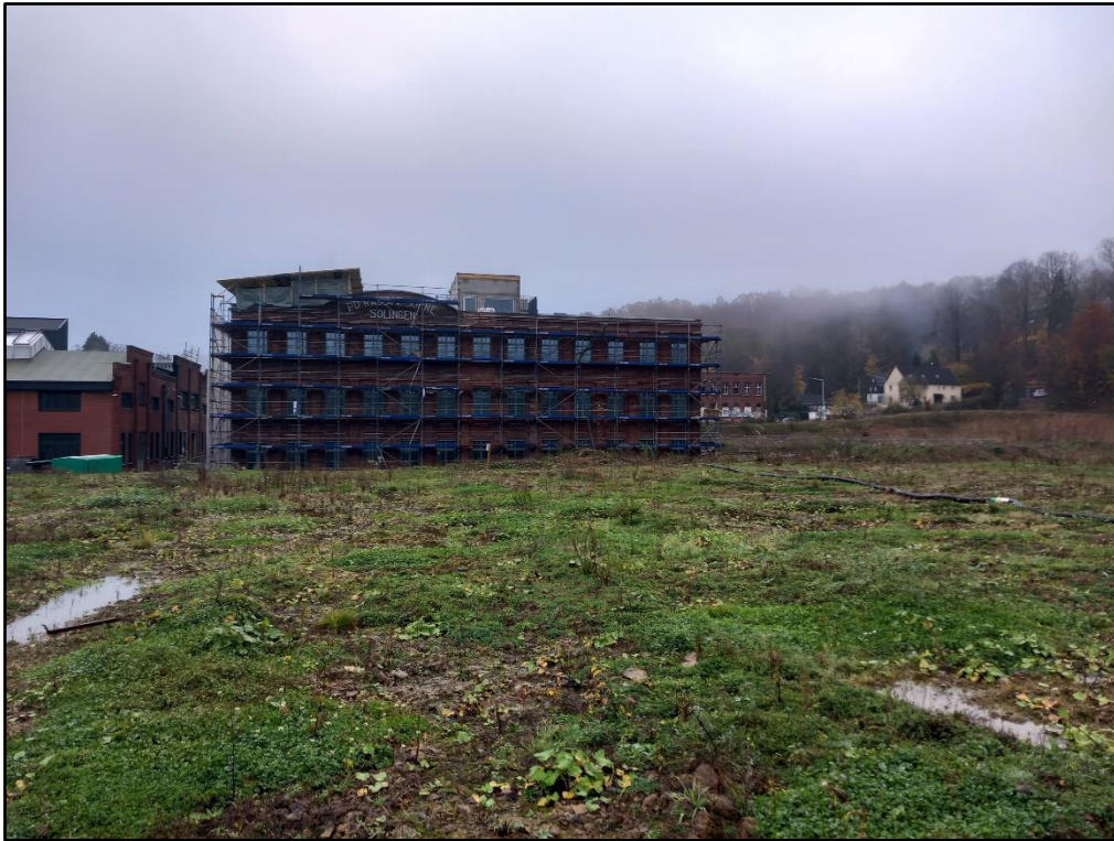
Abbildung 3: Blick Richtung Süden, im Hintergrund das in der Sanierung befindliche Gebäude B7.
