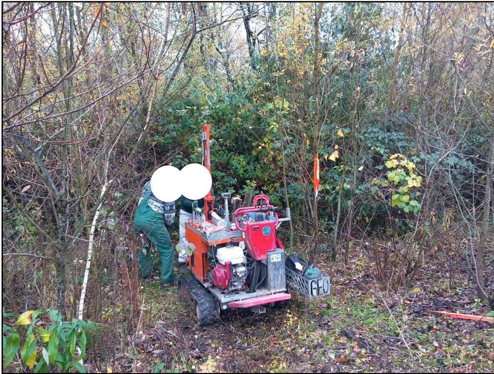
Abbildung 11: Durchführung einer Kleinrammbohrung durch zwei Mitarbeiter des Unternehmens Stiehl Geoservice.
