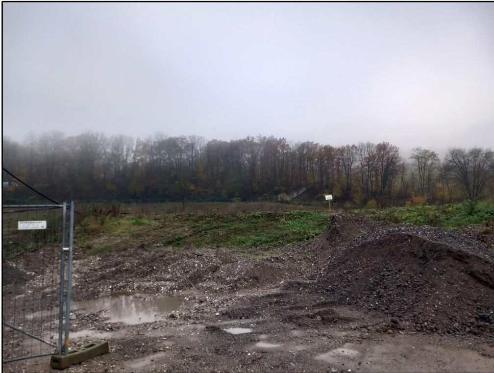
Abbildung 1: Ehemalige Baustelleneinrichtungsfläche, Blick Richtung Norden, ehemalige Flächen der Gebäude B8 und B9.
