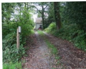
Favorisierte Befestigung mit Grauwacke im Außenbereich: wasserdurchlässig, passierbar für Kleintiere.
